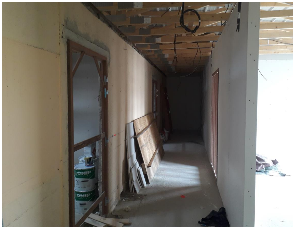
COULOIR MENANT AUX TOILETTES ET AU LOCAL TECHNIQUE
